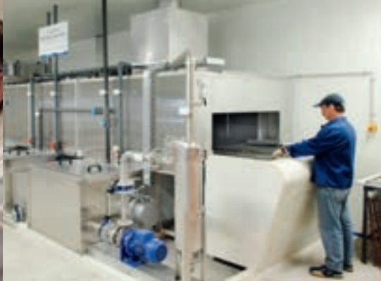
Individuelle Vorbehandlung der Oberflächen
